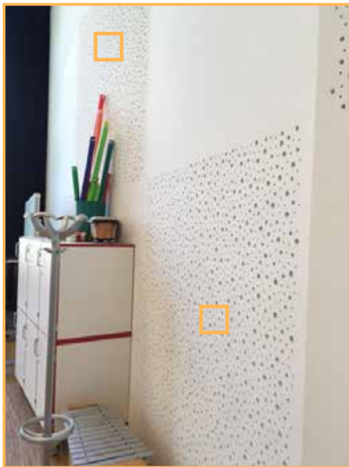
↑ FOTO 24: Schallabsorbierendes Material im Musikraum, Lycée Ermesinde Mersch, Luxemburg
