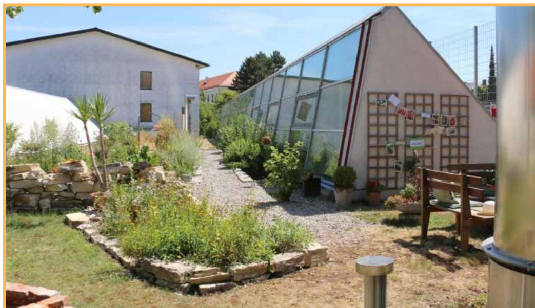
↑ Foto 5: Gartengestaltung auf dem Dach der Turnhalle, Descartes Gymnasium Neuburg, Deutschland
