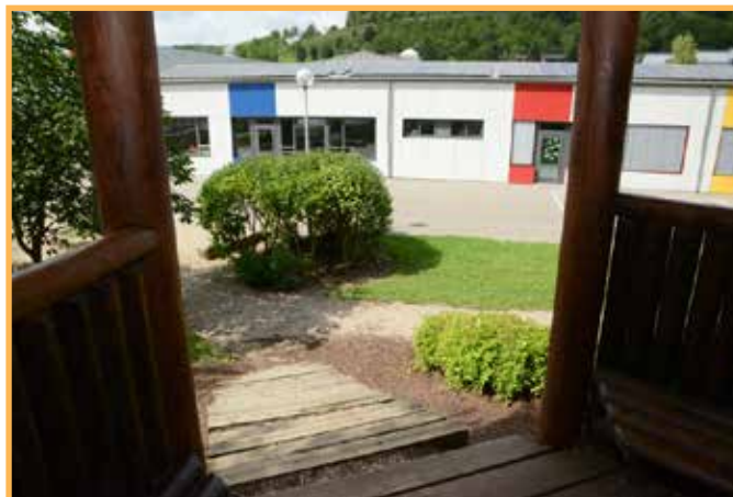
↑ FOTO 42: Nischen und Übergänge im Außen, Grundschule Lorentzweiler, Luxemburg
